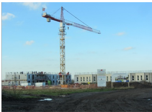
Logements en construction. Sources : Photo Perspectives Urbaines et Sociales
